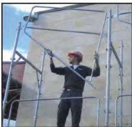
Montaggio parapetto Parapet assembly Montage du garde corps
