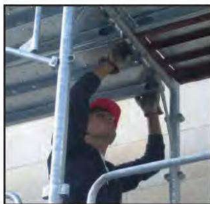
Montaggio tavola Table assembly Montage du plancher
